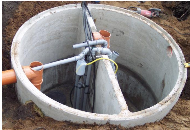
Bild 2 Eingebaute Klärtechnik
