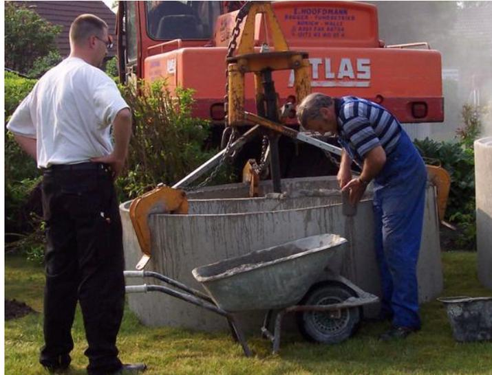
Bild 9 Vermörteln der Fuge
